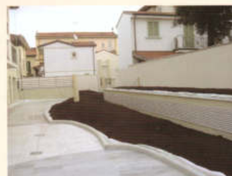
La posa del substrato di coltivazione composto da substrato minerale, agriperlite e torba bionda
