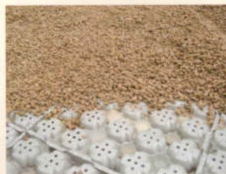
Strato drenante tipo Geodrein spessore 6 cm circa su tutta la superficie dell'aiuola e successivo riempimento degli interstizi con lapillo vulcanico
