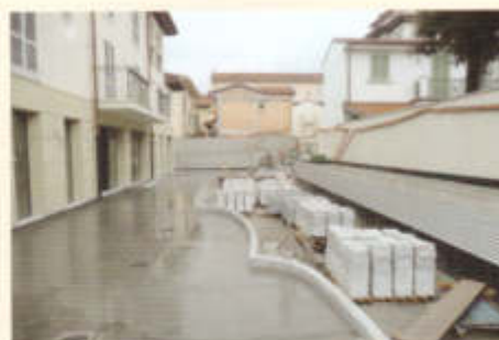
La realizzazione dei cordoli di contenimento e preparazione della struttura del giardino
